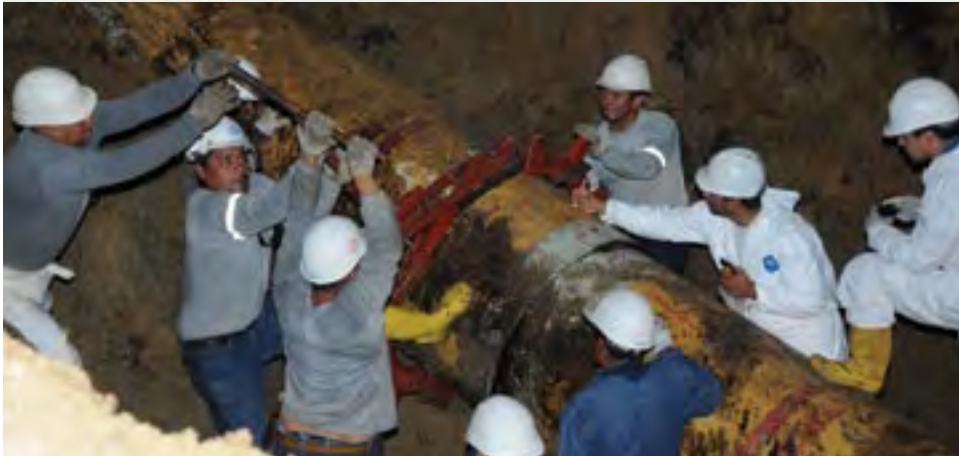
Tareas de reparación en la zona de la rotura de la tubería.
