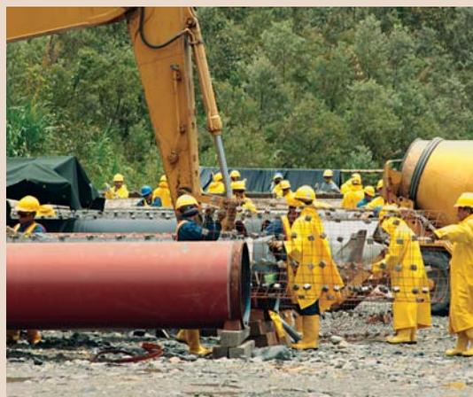
Parte de la tubería es recubierta con concreto para que gane mayor peso, a su vez sirve de protección externa.
